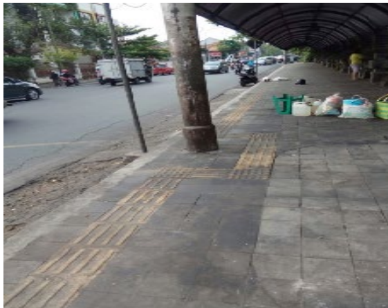
Gambar 18. Lintasan ubin pemandu yang justru menyulitkan tunanetra
