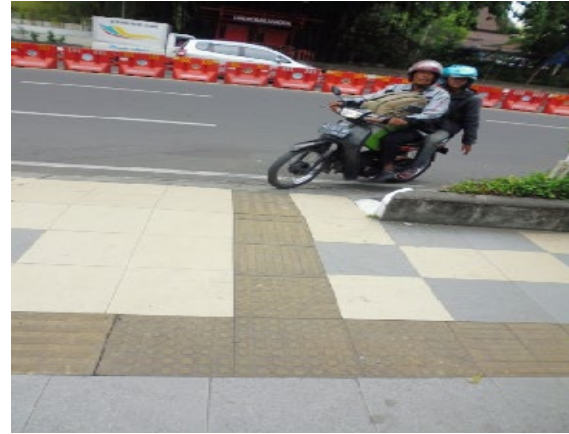
Gambar 19. Ubin yang mengarahkan pengguna ke tempat berbahaya
