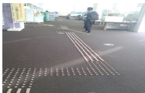
Gambar 5. Ubin tekstur pemandu di dalam salah satu kantor pelayanan publik di Kota Nagoya
