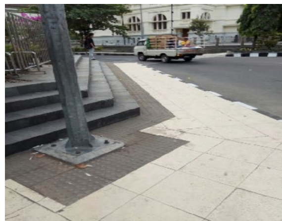
Gambar 16. Ubin yang terlalu dekat dengan tiang dan berpotensi membahayakan tunanetra
