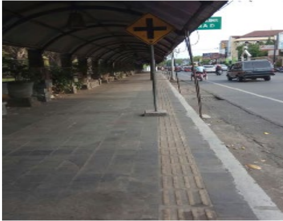
Gambar 17. Ubin yang terlalu dekat dengan tiang dan berpotensi membahayakan tunanetra
