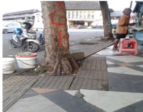
Gambar 15. Jalur ubin yang sangat menyulitkan tunanetra
