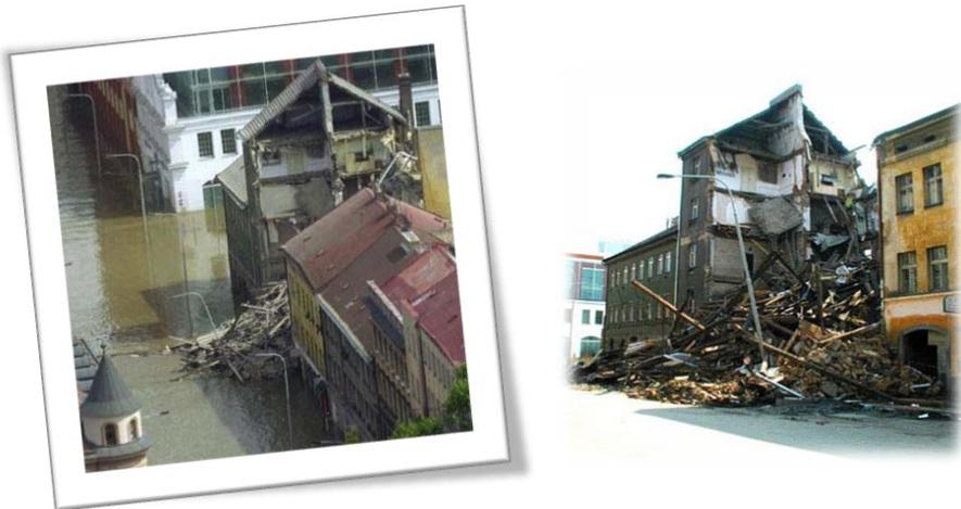
Foto 3 dan 4. Bangunan banyak-cerita ini runtuh saat kota dilanda banjir (kiri). Keruntuhan salah satu bagian dari bangunan tersebut masih secara jelas terlihat (foto yang dilaporkan oleh Radio Prague) (kanan). Data diambil dari Risk Management Solutions tentang Central Europe Flooding, August 2002: Event Report.
